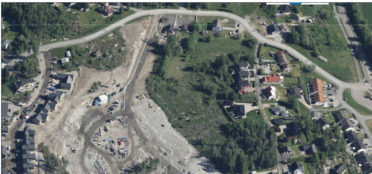
Skråfoto fra 1881.no, som viser nytt boligområde like i vest der det er under oppføring nye boliger.
