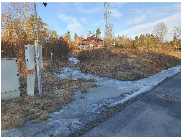
Bilde 3-5: "Bekkeutløp" ved GS vei langs Osloveien.
