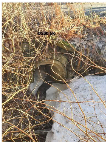
Bilde 3-2 Ø500 btg stikkrenne under Åsfaret
