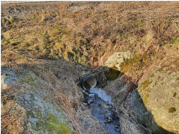
Bilde 3-3: Utløp Ø400 DV kulvert under Tangenveien
