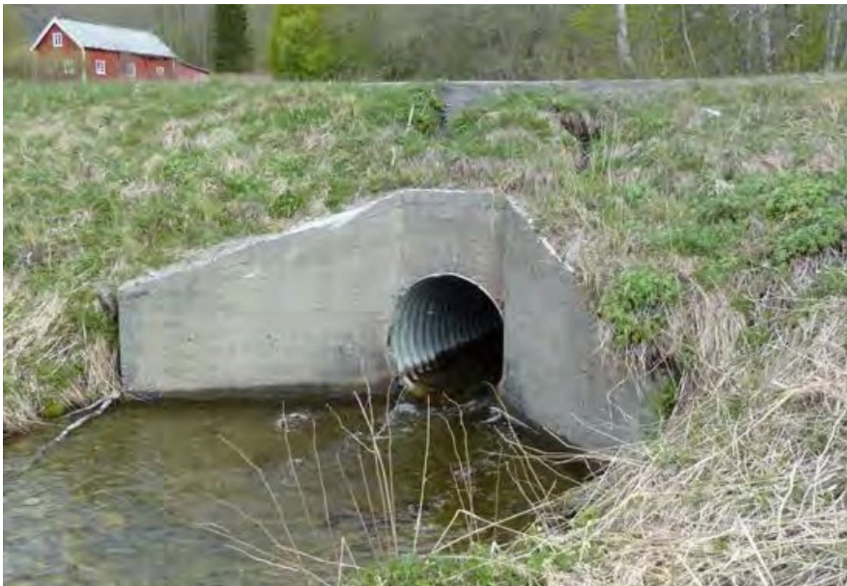
Figur 3 Eksempel på V-formet inntak.
