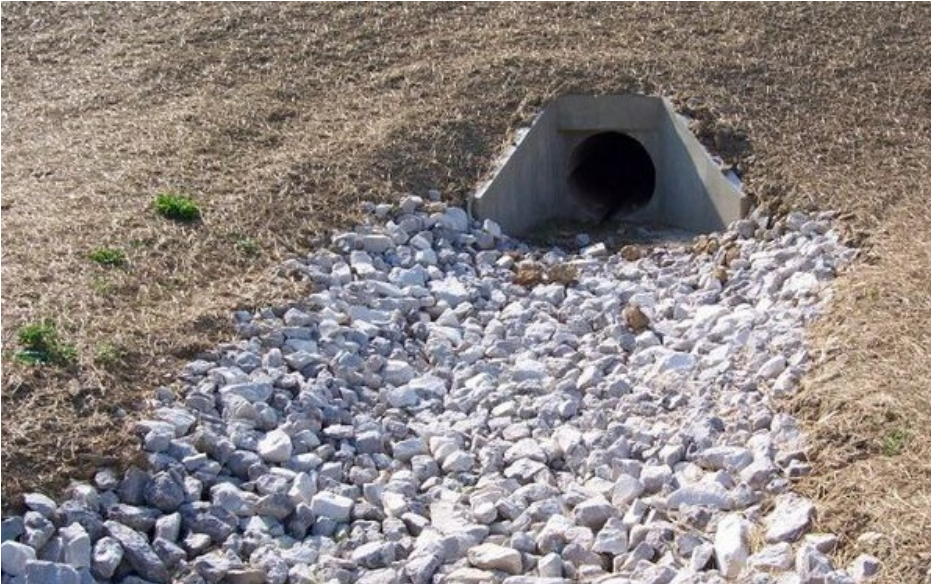
Figur 4 Prefabriert kulvertutløp med steinsatt strekning nedstrøms
