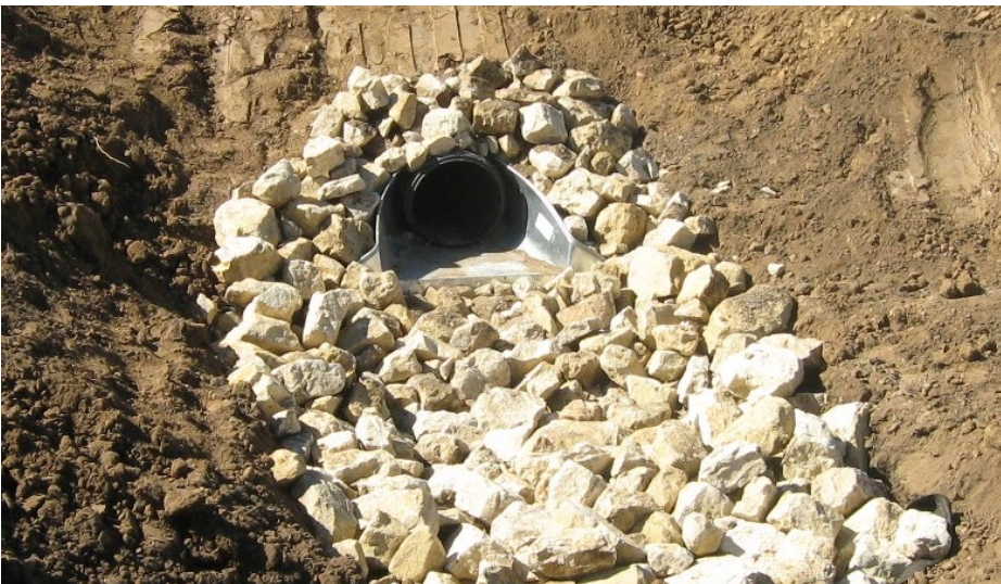
Figur 5 Variant av steinsatt utløp
