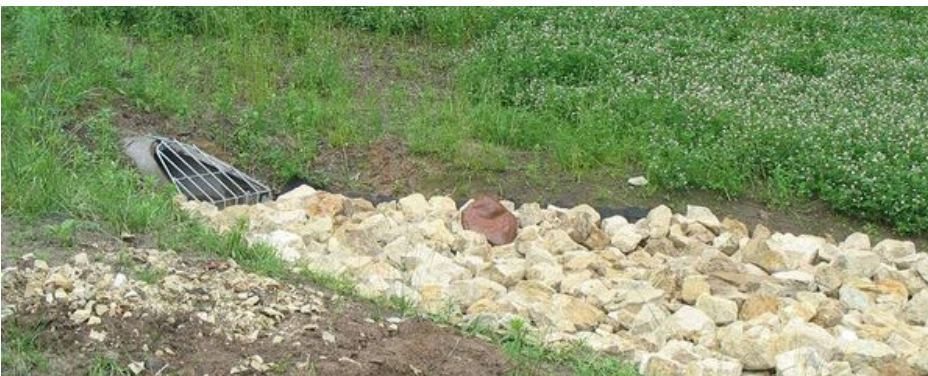
Figur 6 Variant av steinsatt utløp.
