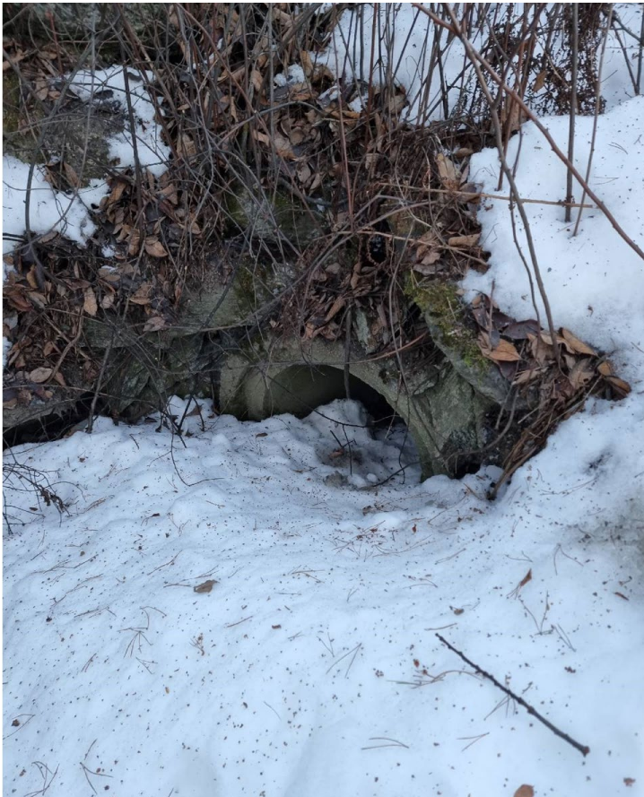
Figur 2 dagens kulvertinntak (B) oppstrøms Åsfaret
