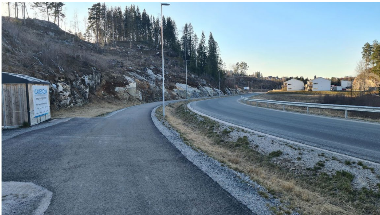
Figur 7: Bilde tatt mot bergskjæring vest for Ringveien
