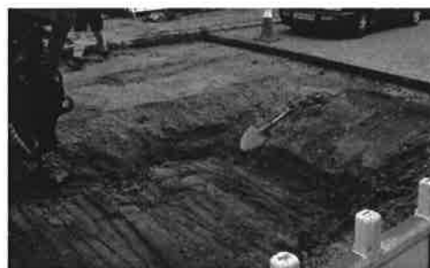
Utkiling med 50 cm kant til asfalt
