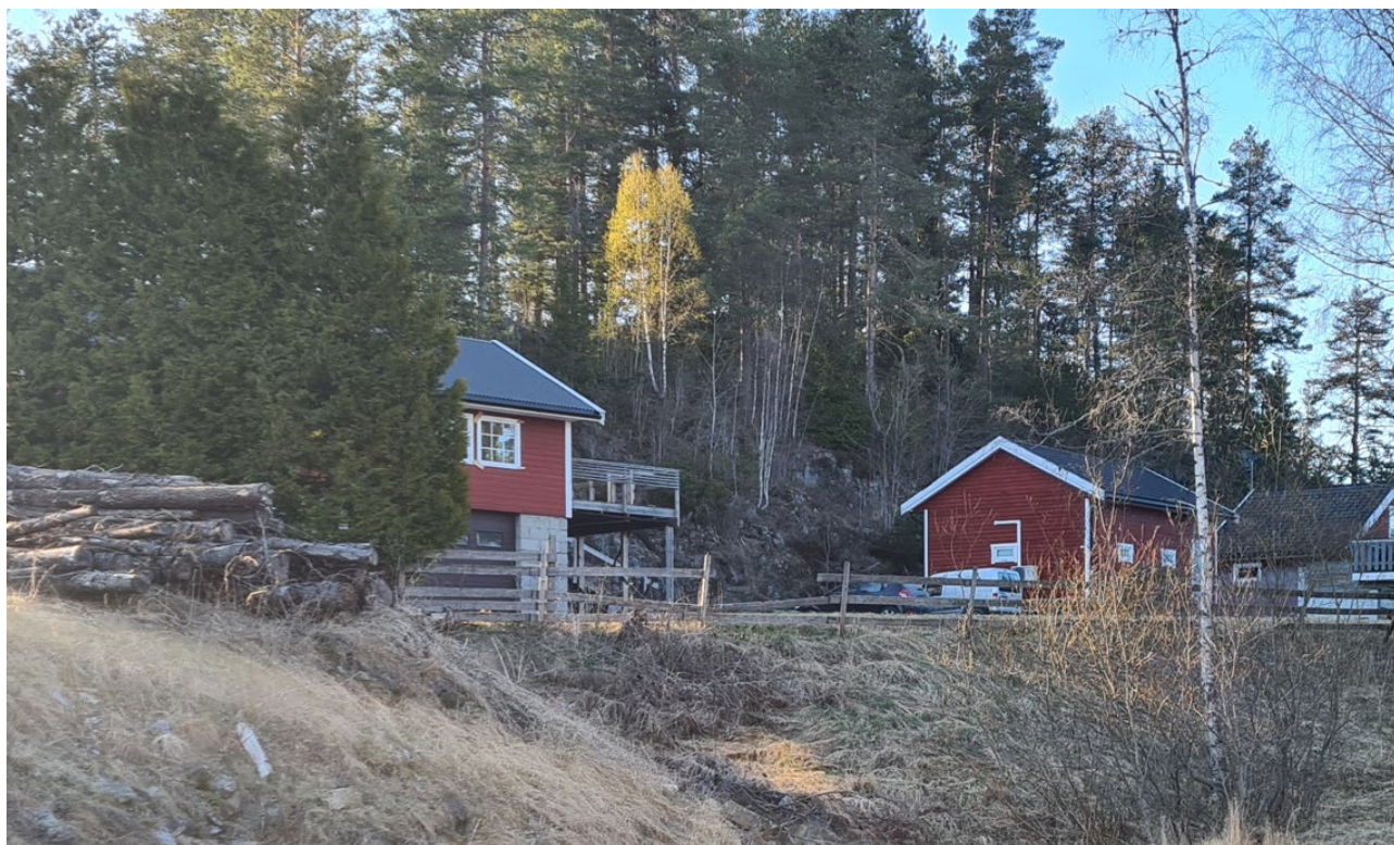
Figur 10: Bilde mot Kjensliveien 27. Fjell i dagen i bakkant.
