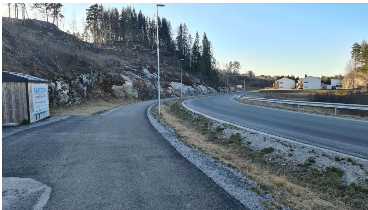
Figur 6: Bilde tatt mot bergskjæring vest for Ringveien
